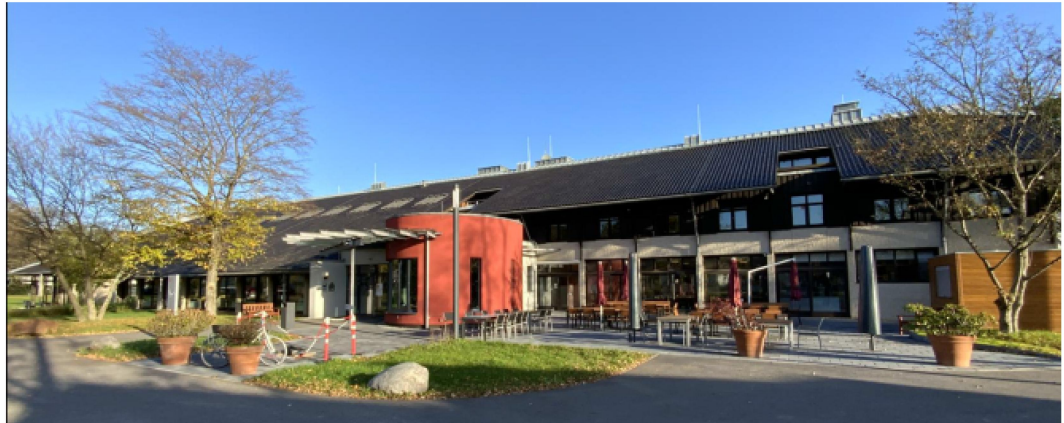
Zugangseite / Vorderfront des Hauptflügels mit Hauptzugang zur Anmeldung
