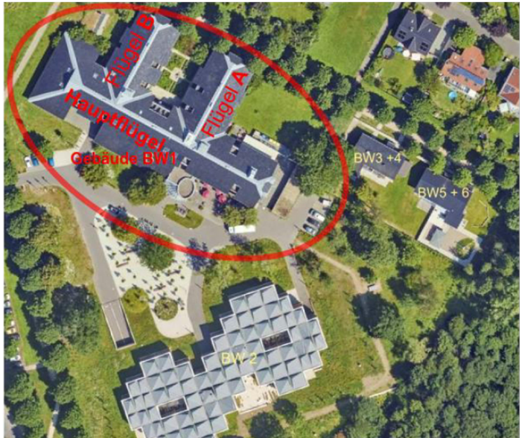
Luftbild Gebäude BW1 und Gelände
